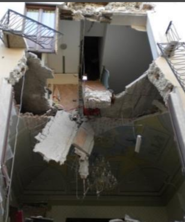
Building with collapsed vaults built with brick 'in foglio', in the Piazza di S. Pietro di Coppito
